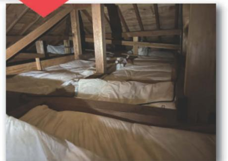
施工後 従前よりある断熱材の上に高性能グラスウール100mmを全面に隙間なく敷き詰め、屋根裏からの熱を室内に通しません
