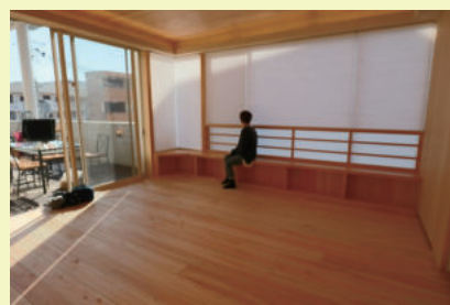
完成後 西側の造作棚はベンチにも
